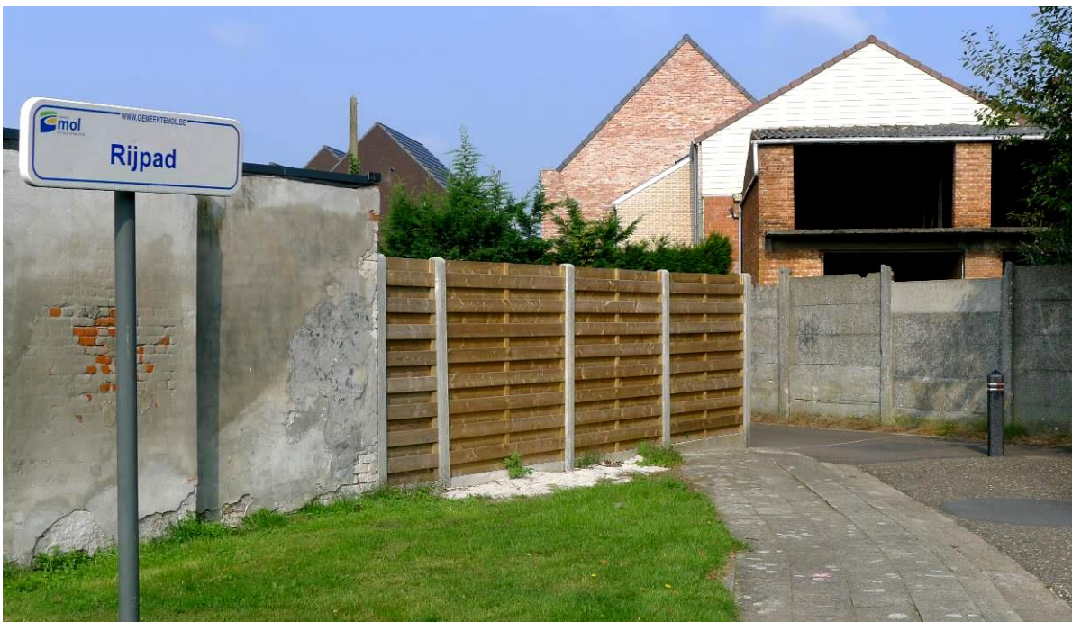
2014 – De inrit van de Rijpad met de betonnen stichel van aannemer Rik Heylen en met een houten afsluiting van de tuin van de eerste woning van het Peerdskerkhof.
