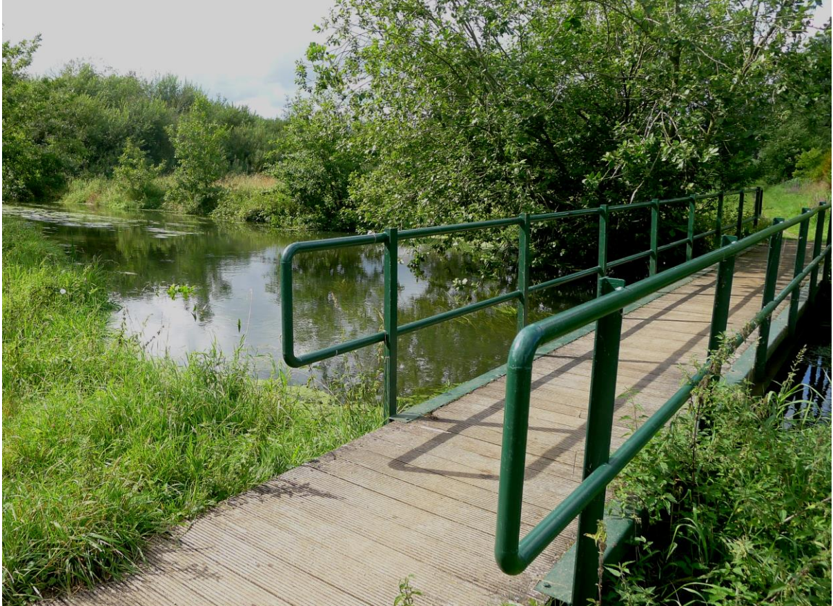
De vernieuwde brug van het 'Schabberdekske' over de MolseNete.
