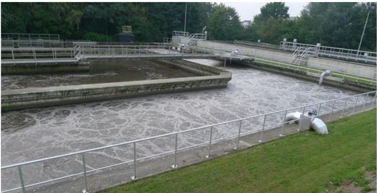
Het kolkende water in de beluchtingsbekkens waarin zuurstof is geblazen.
