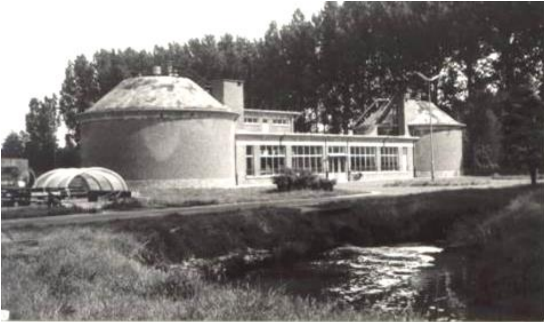
1964 – De hoofdingang met het administratief gedeelte en de twee digestors. (Krantenfoto)
