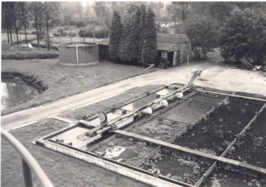
1964 - De droogbedden van het slib, de gashouder en de opbergruimtes langs de meanderende Molse Nete. (Krantenfoto)
